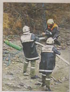
Vier Feuerwehren waren im Einsatz. Foto: FF Lienz
